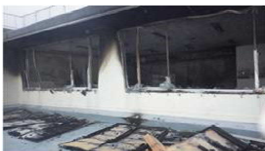
2階部分（外から）
