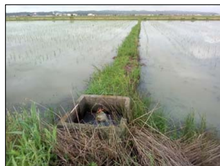
【水田に設置された用水の給水栓】
