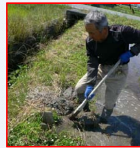
排水側管理 ⇒遠隔操作を検証
