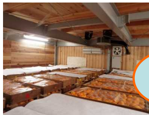
既存の貯蔵施設に冷風設備を追加
