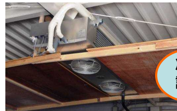
既存の貯蔵施設に冷風設備を追加
