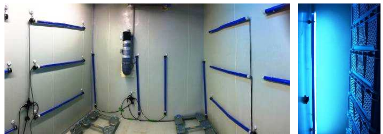
10m 3 貯蔵庫（2～2.5t入庫）におけるLED設置事例
