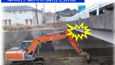
車両作業時に橋桁を損傷
