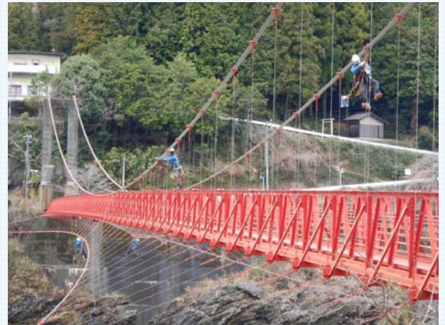
「建設産業の部」最優秀賞 (竜山橋にとりつくスパイダーマン)
