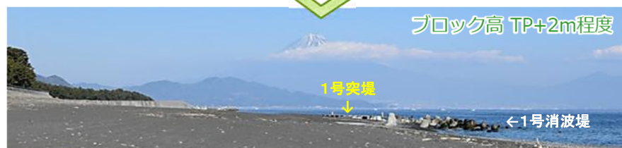
令和5年1月 (②ブロックの一部を撤去)
