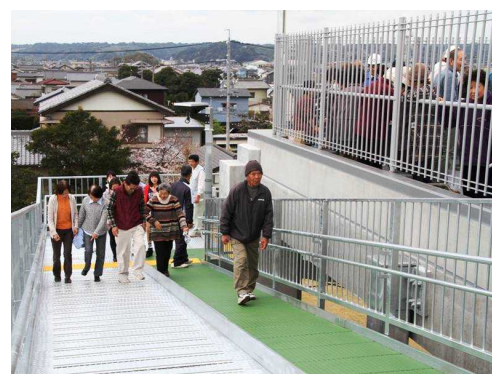
津波避難タワー（牧之原市）
