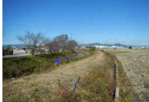
写真 2-1 焼津市高新田付近築堤区間
