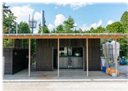
森の金太郎発電所の外観
