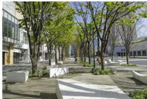
図表 2-29 雨水貯留砕石層上部のケヤキ並木
