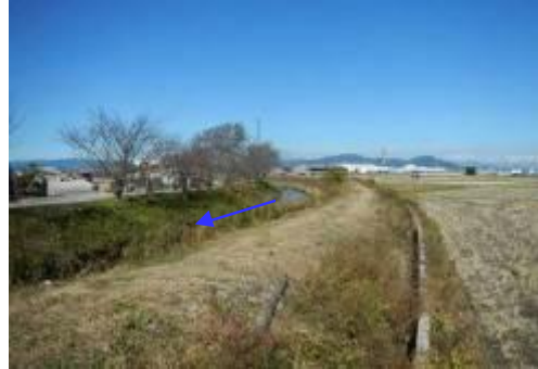
写真 2-1 焼津市高新田付近築堤区間
