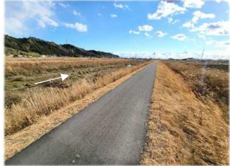
図 4-7 堤防天端舗装（掛下橋付近）
