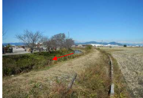
写真 2-1 焼津市高新田付近築堤区間
