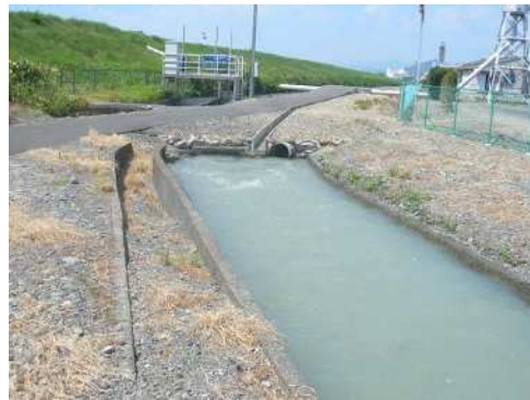
写真 2-2 大井川用水から分派し志太田中川流域に流入する一番用水
