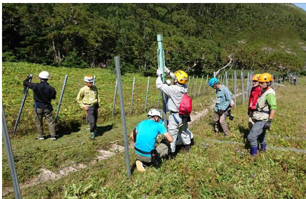
防鹿柵の設置作業(三伏峠)
