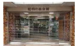
昭和の森シャッター交換
