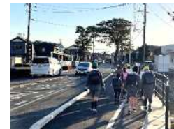
通学路の歩道整備
