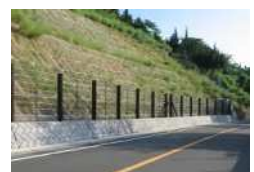
道路防災対策
