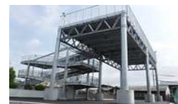
津波避難タワーの整備
