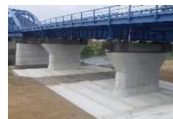
橋梁の橋脚補強工
