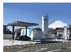
水素ステーション（御殿場）
