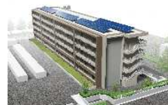
屋上に太陽光発電パネルを設置
