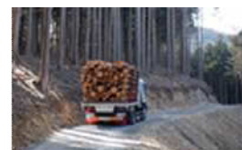
生産団地内のトラック道整備
