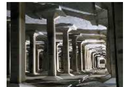
耐震化が完了した貯水池
