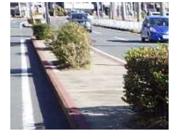
防草対策による通行空間の改
