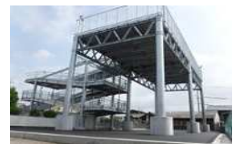
津波避難タワーの整備
