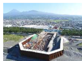
沼川新放水路防潮堤
