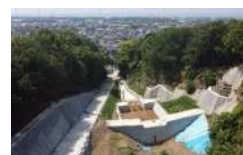
砂防堰堤の整備：掛川市大坂沢
