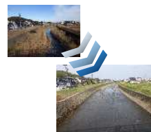
河道掘削：島田市岸町
