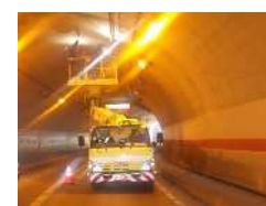
トンネル点検
