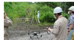
現地確認の様子
