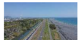
静岡モデル防潮堤 （吉田町川尻工区）
