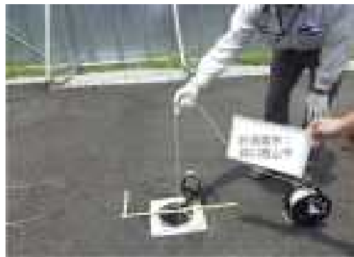
図39.地下水位の計測状況(井川西山平)
