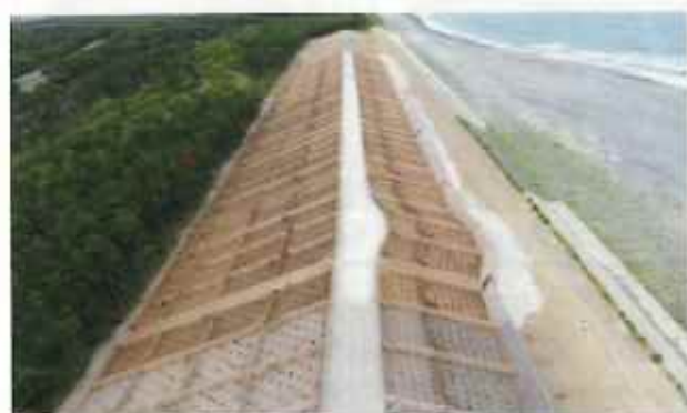
“ふじのくに森の防潮堤づくり”完成箇所（磐田市中平松）
