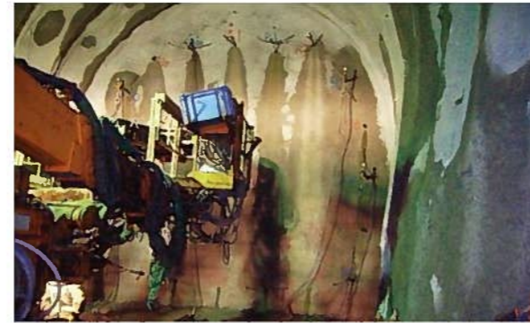
写真 薬液注入工の施工例
