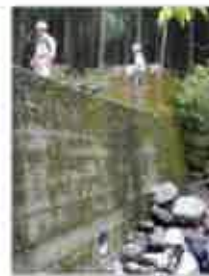
治山施設の点検
