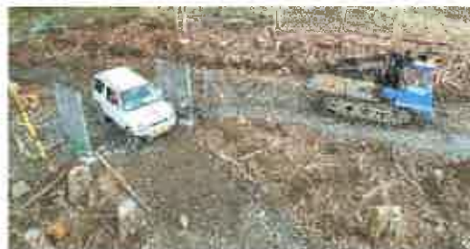
門扉を設置した金属柵
