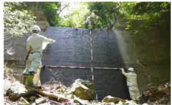
治山ダムの点検（浜松市浜名区西久留女木）
