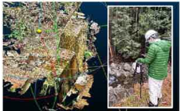
LiDAR測量機器を活用した治山ダムの測定 （藤枝市滝沢）
