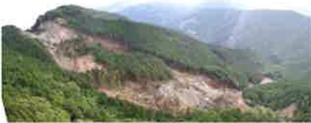
大規模地すべり崩壊地（静岡市葵区諸子沢）
