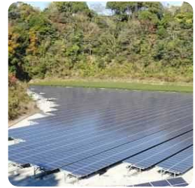
太陽光発電施設
