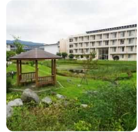
環境に配慮した宅地整備
