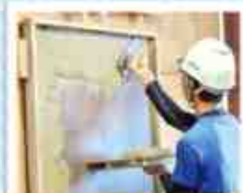
「こて」を使い、壁を塗って仕上げる様子
