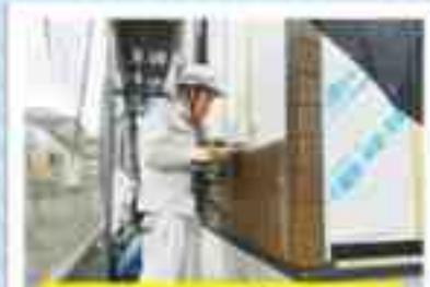
住宅の外壁も板金の仕事
