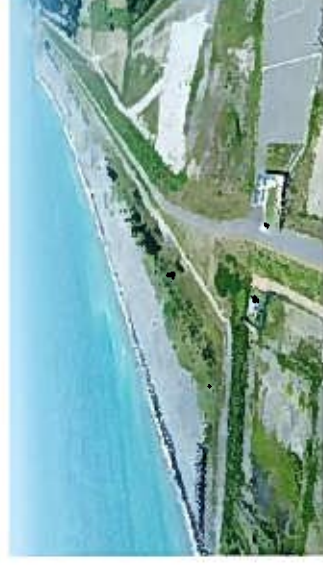
フロントエリア推進エリアにおける 防災・減災対策のための防潮堤整備 (吉田町)
