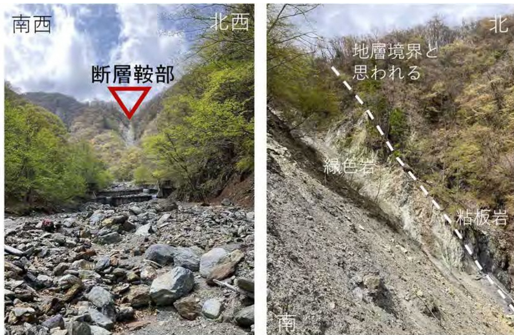
写真 2 調査 2 地点断層鞍部遠望と露頭状況
