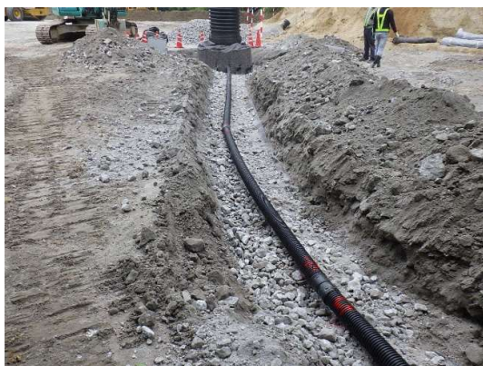
写真 3 水平排水工及び縦排水工の例
