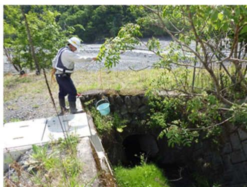
写真 7 放流する水の水質の確認
