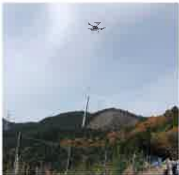
ドローンを用いた資材運搬
