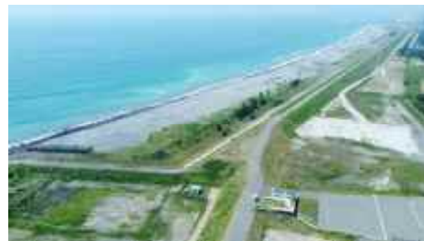
フロンティア推進エリアにおける 防災・減災対策のための防潮堤整備 (吉田町)
