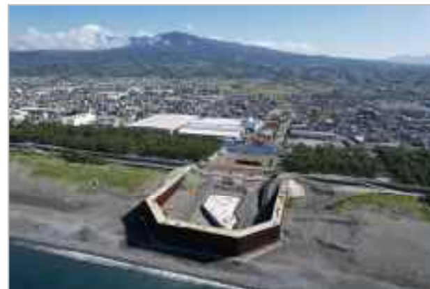
浸水被害を軽減させる 沼川新放水路の整備(沼津市)
