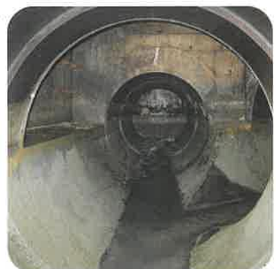
岳南排水路の管の中です。
