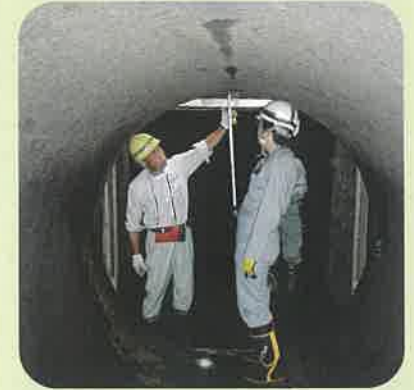
排水路の中で点検しています。
