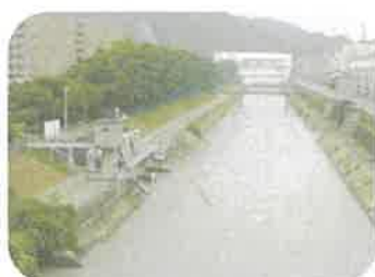
ふじさん工業水道 蒲原取水場で取水して
