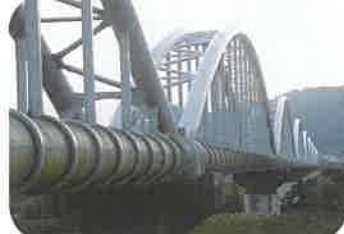
富士川水管橋を通り
