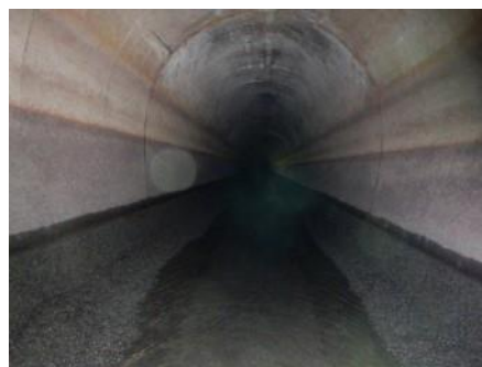
トンネルは馬蹄形のトンネルです。
