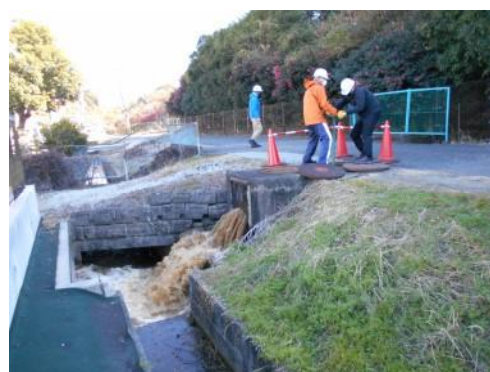
洗管(排水)作業中
