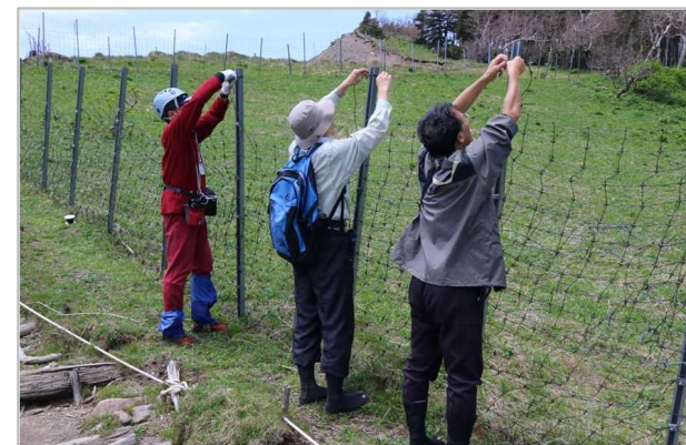
南アルプスの環境保全(防鹿柵の設置)
