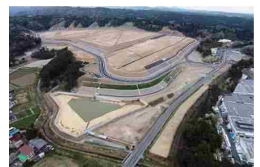
下野部工業団地造成完了
