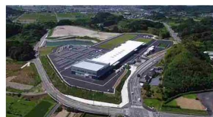
西工区(大坂・土方工業用地)整備状況
