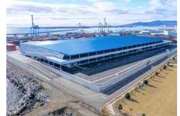
Lv2津波にも対応する物流施設
