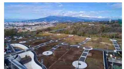
三島塚原地区住宅団地造成完了
