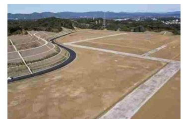
浜名湖西岸地区造成状況
