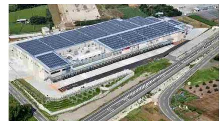
災害に強い物流施設
