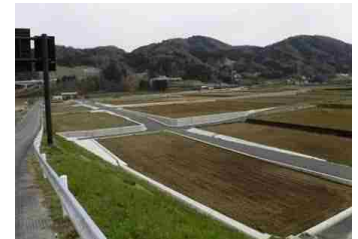
農業基盤整備完了
