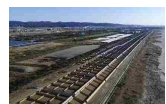
防潮堤の整備
