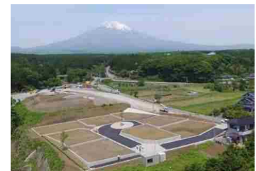
造成が完了した住宅地
