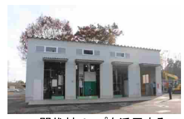
間伐材チップを活用するバイオマスプラント
