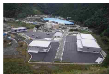
整備された物流団地
