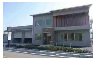
西消防署北分署の建設
