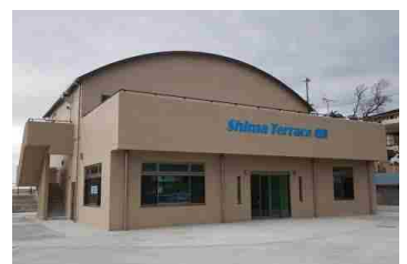
初島漁港交流広場・休憩施設
