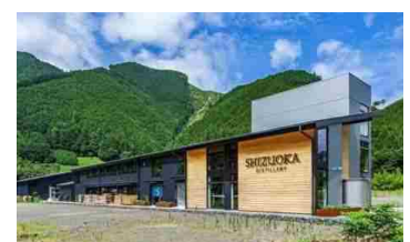
地域資源(麦芽、仕込み水)を活用したウイスキーの製造工場
