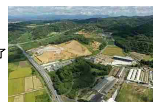
工業団地造成状況
