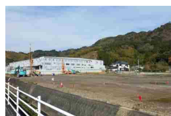
造成された物流団地(北側工区)
