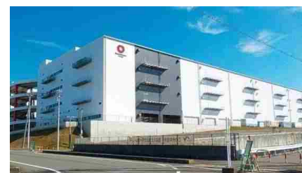
完成した大規模物流施設
