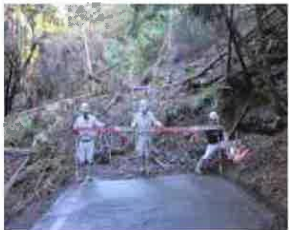
林道前谷線の被災状況（浜松市天竜区只糸）
