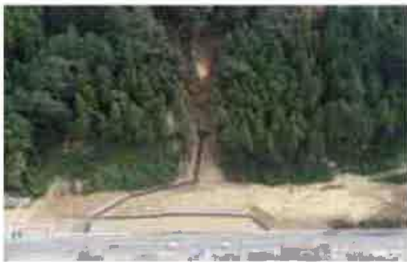
磐田市神増（応急復旧工事完了後）
