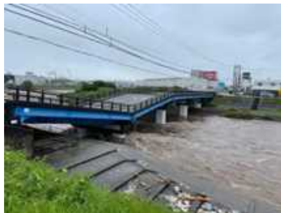
■ 令和3年7月豪雨での被害（黄瀬川）
