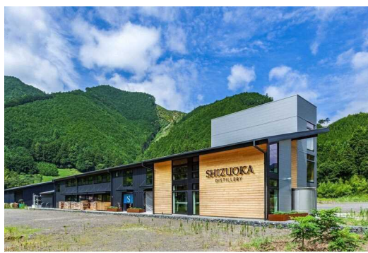
■ 新たな地域資源となるウイスキー工場（静岡市）
