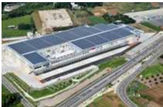
■ 新東名高速道路 I C 周辺に立地した物流施設（長泉町）
