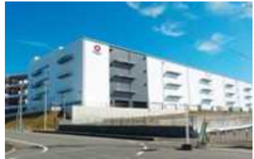
■ 造成された工業用地に立地した物流施設（富士市）
