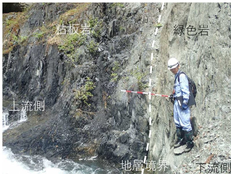
写真 2 調査1地点露頭状況（内河内川左岸側）
