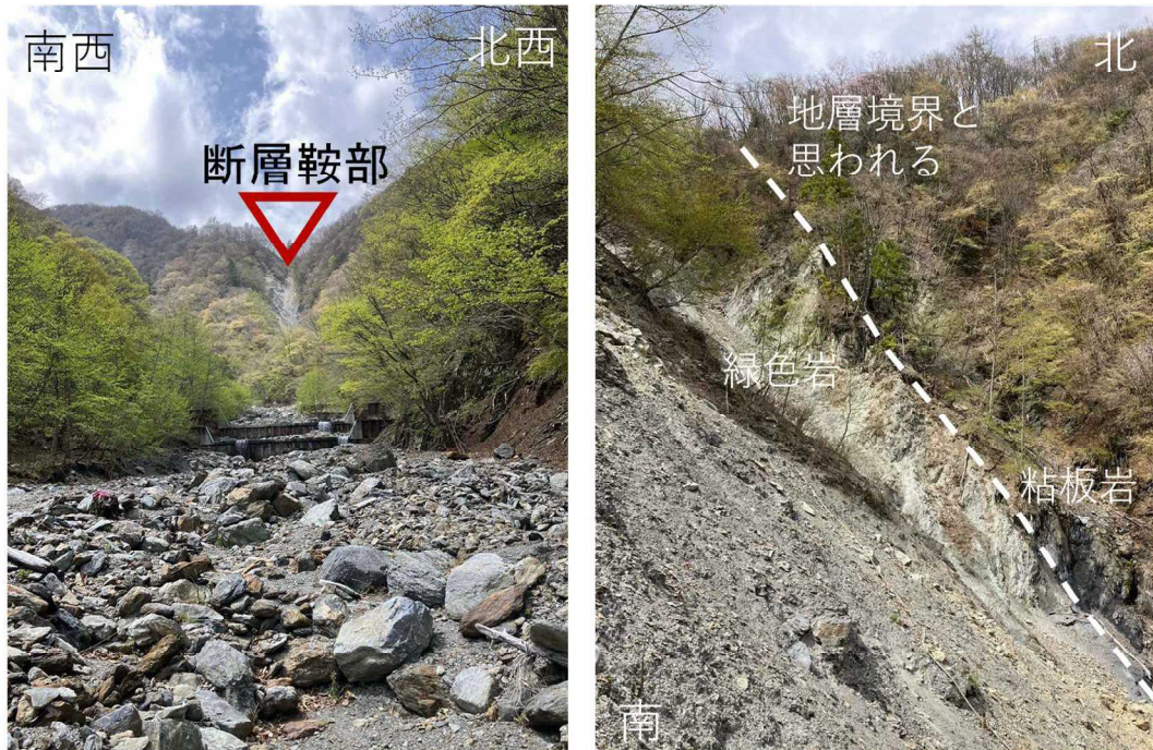
写真 3 調査 2 地点断層鞍部遠望と露頭状況
