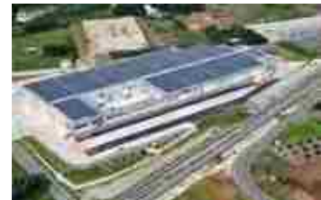
災害に強い物流施設
