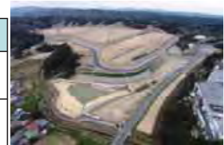
下野部工業団地造成完了
