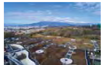
三島塚原地区住宅団地造成完了
