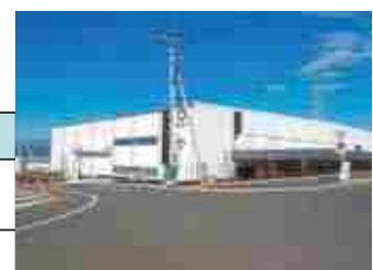
完成した物流施設
