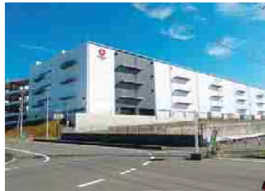
【富士市】物資拠点となるテナント型大規模物流施設
