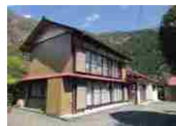
空き家を活用したサテライトオフィス
