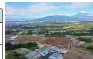
三ツ谷工業団地造成完了
