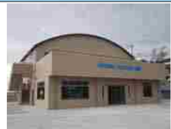
初島漁港交流広場・休憩施設完成
