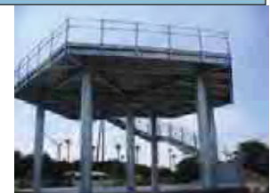
津波避難タワー
