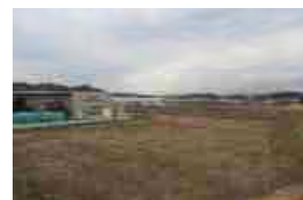
農地造成工事完了
