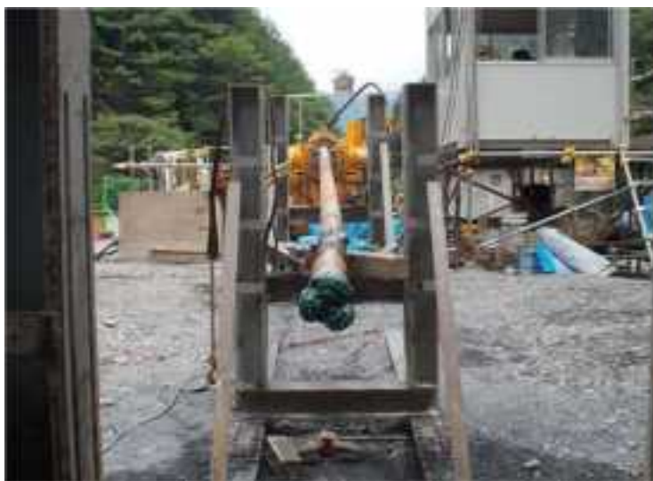
写真 4 高速長尺先進ボーリング（山梨工区）
