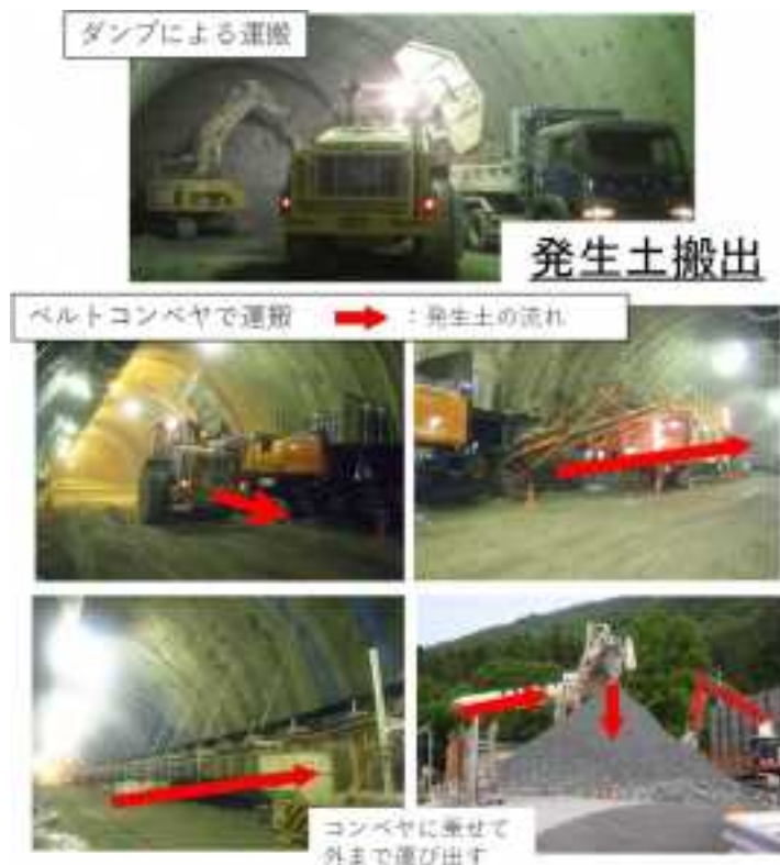
写真 2 発生土の搬出状況
