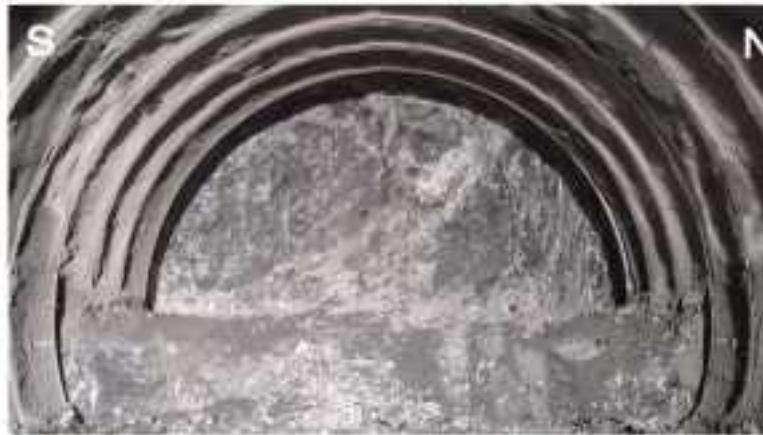
写真 7 先進坑 2 k 7 7 2 mにおける切羽状況
