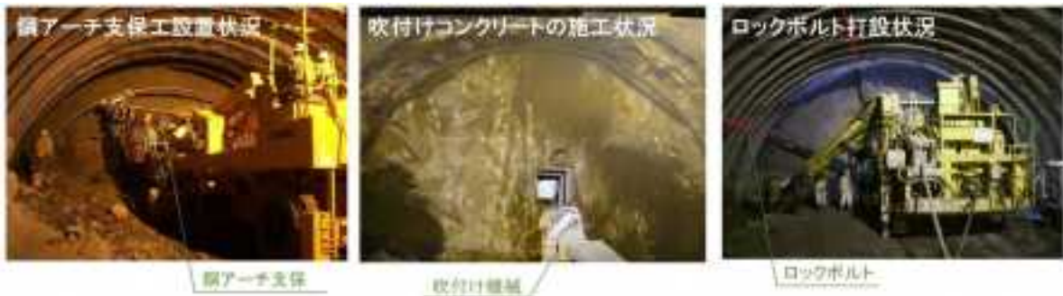
写真 3 支保工の施工状況
