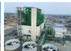
米子バイオマス発電所 (2022年4月運転開始)
