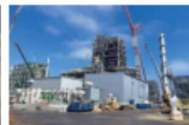
神橋バイオマス発電所 (工事状況)
