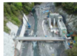
安曇川水力発電所 (えんじ工事状況)
