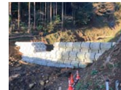
2 既設堰堤上流の掘削状況
