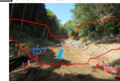
5 ネットロール土のう設置状況(完成)
