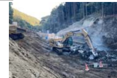
3 仮設ブロック堰堤②設置位置
