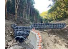
5 ネットロール土のう設置状況(完成)
