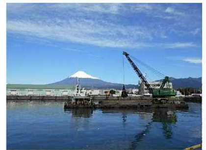
汚染底質の除去（浚渫）作業
