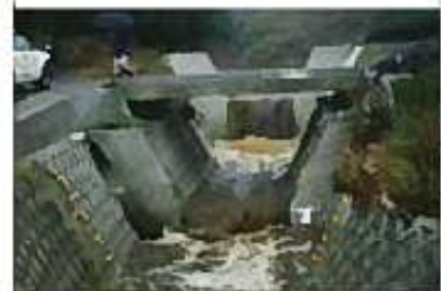
集めた雨水を安全に流下 (落差を設け流速を抑制)
