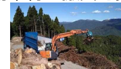
大型トラックによる搬出の効率化
