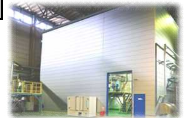
CNF強化樹脂実証生産設備
