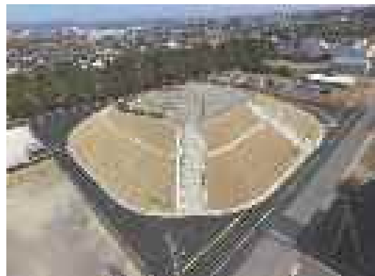
【湖西市】発生した土砂を利用して整備した命山（住吉地区）
