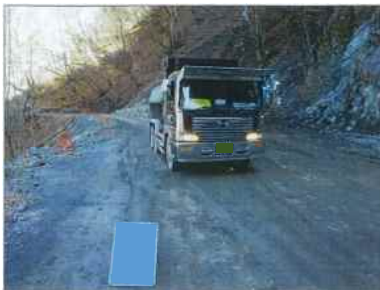
写真2. 3 ダンプトラックによる運搬イメージ
