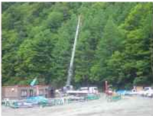
クレーン作業状況
