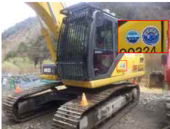
図 4.26 排出ガス対策型、低騒音型建設機械の使用状況
