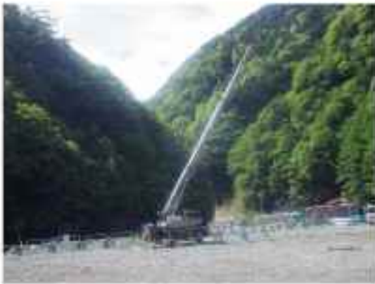
クレーン設置状況
