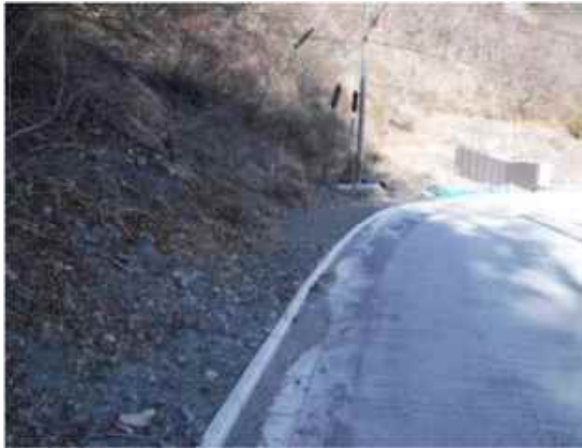
図 4.29 林道東俣線における舗装状況
