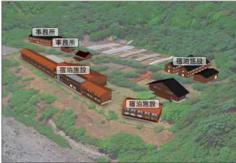
図 1. 16 榑島における工事用宿泊施設の建設
