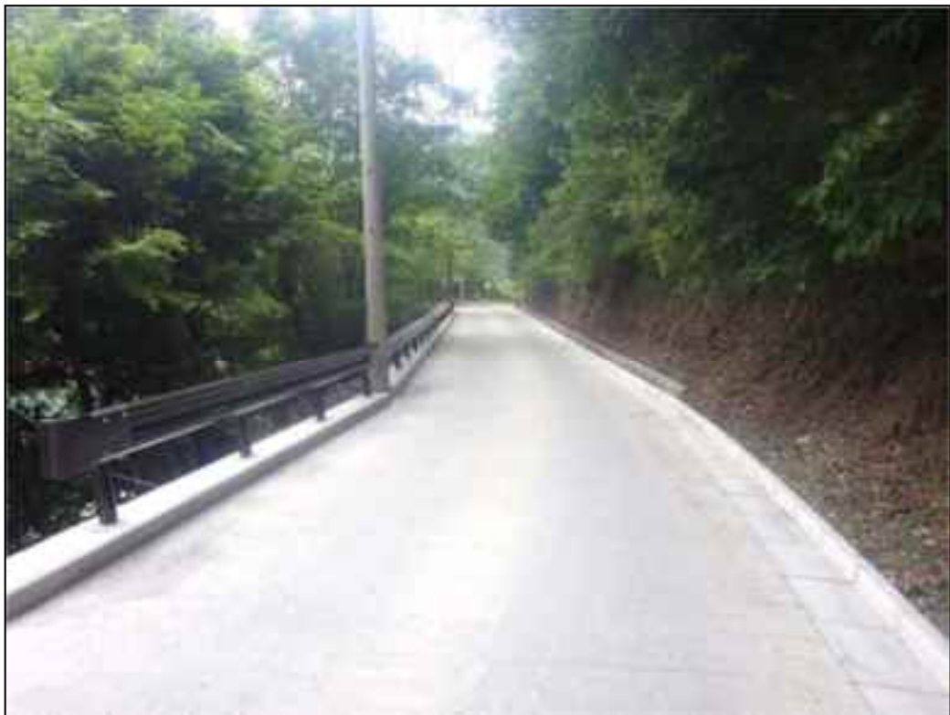
図 1. 15 林道東俣線の改良（舗装）
