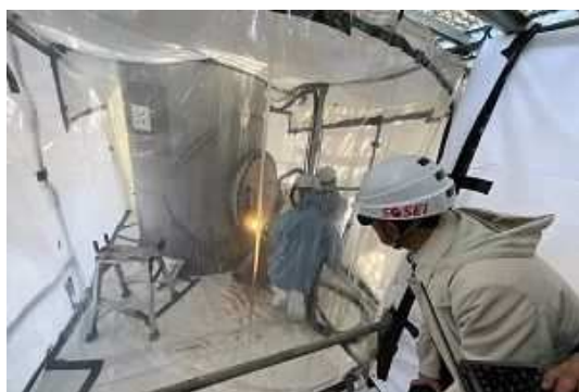
調圧槽での実演施工
