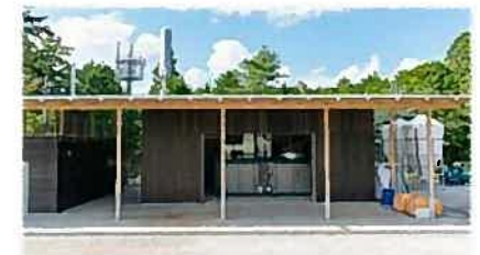
地域材を活用した木質バイオマス発電所（小山町）
