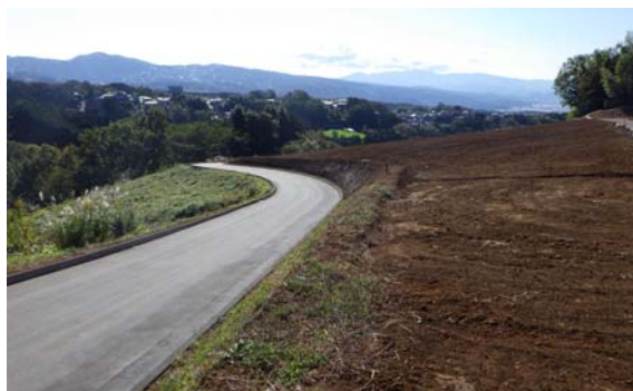
農道整備の状況
