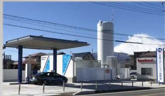
水素ステーション御殿場
