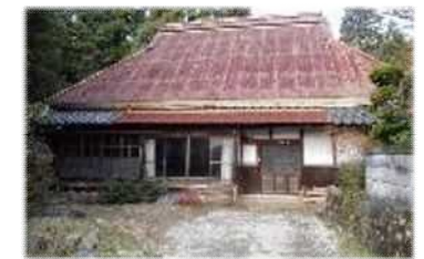
活用前の空き家
