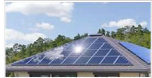
太陽光パネルの設置推進
