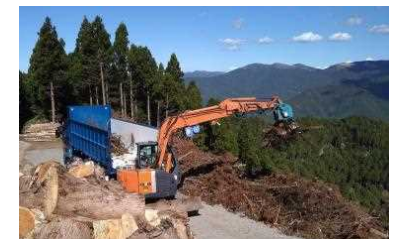
大型トラックによる搬出の効率化 21
